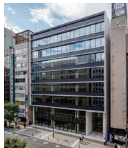
<福岡支店> 2024年7月竣工
