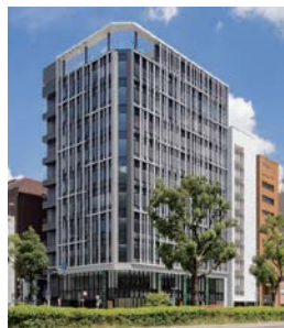
<名古屋支店> 2024年6月竣工
