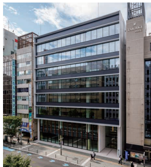
〈福岡支店〉 2024年7月竣工
